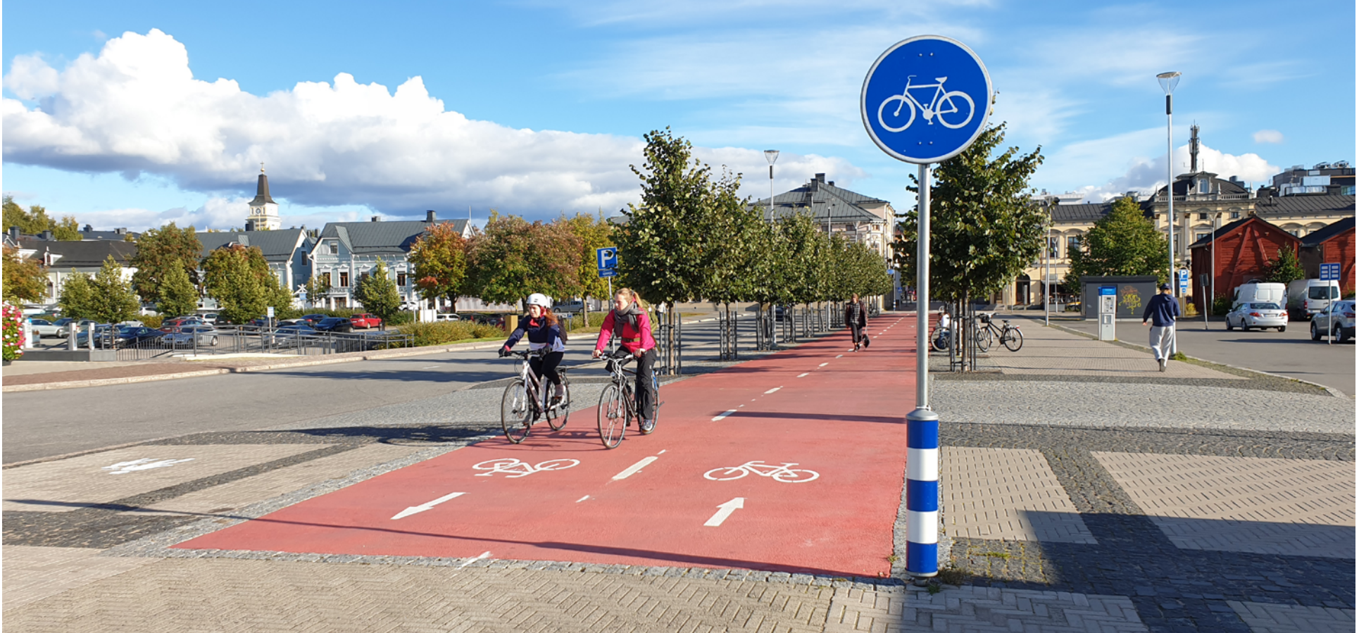
Kuva 25. Pyöräliikenteen väylä on selkeästi eroteltu kävelyalueesta värin, pintamateriaalin, puurivien ja kalusteiden avulla (kuva Oulusta).
